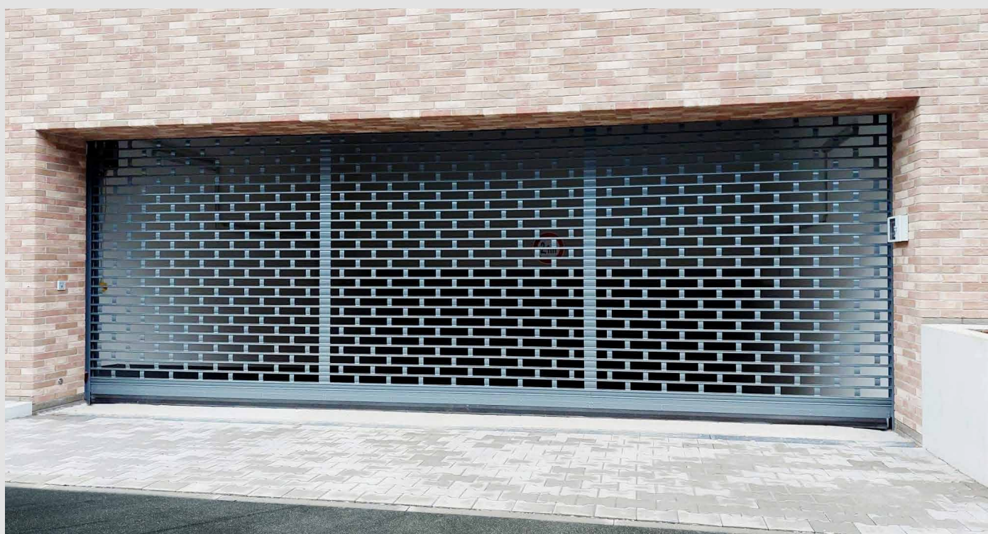
Torausführung mit Stabilisierungsstegen gegen horizontales Verschieben (ab LB > 6000 mm) Torbeschichtung in RAL
