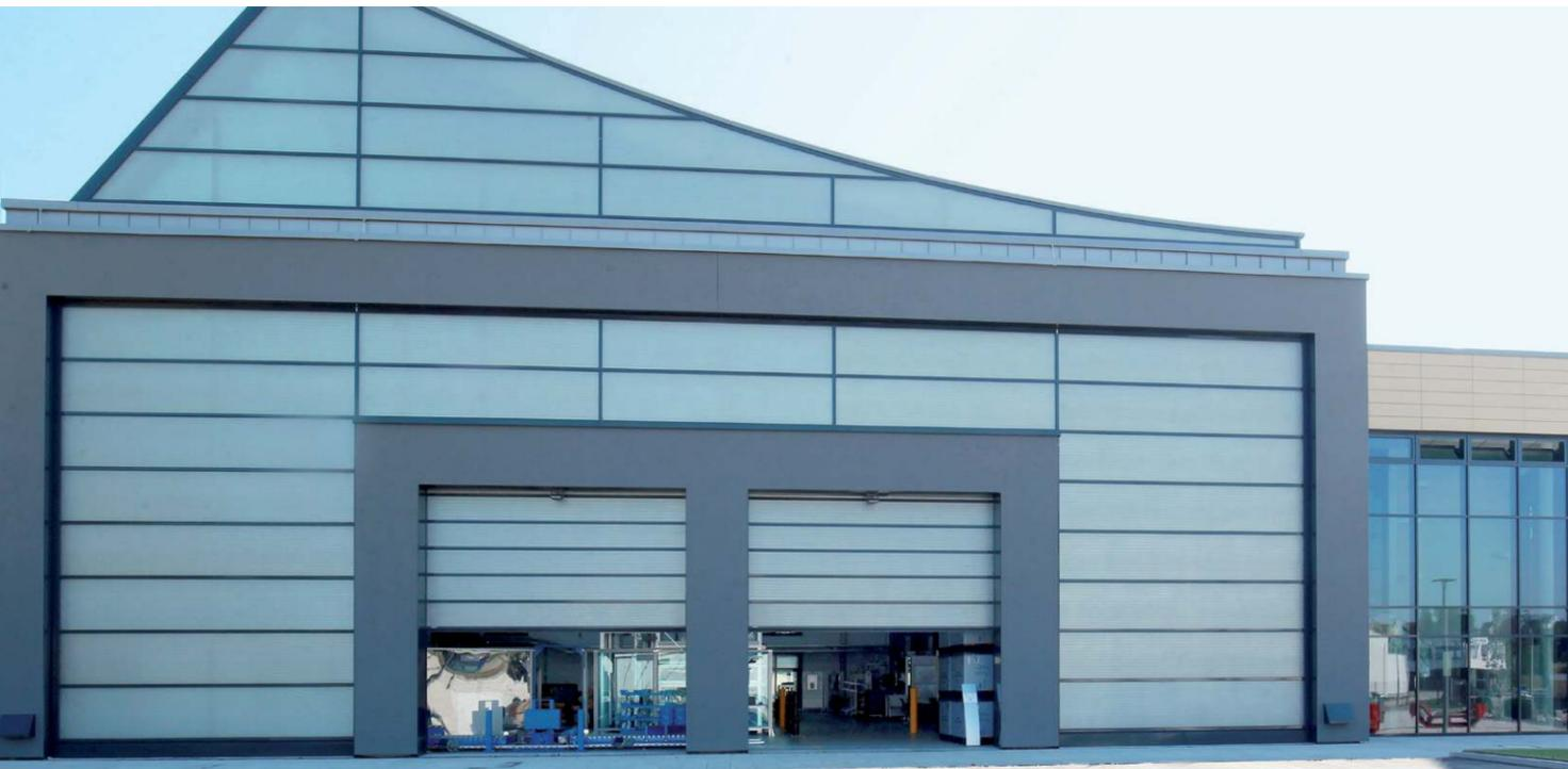
Tor und Fassade aus lichtdurchlässigem Fiberglas überzeugen aus gestalterischen und ergonomischen Aspekten.
